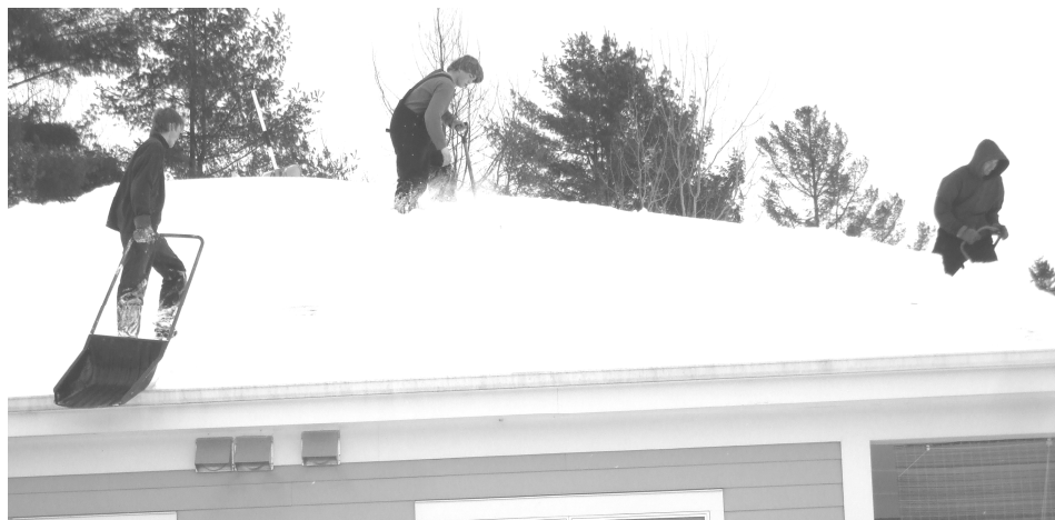
Clearing Cabot Commons roof.
